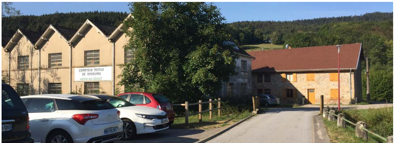
bâtiments du comptoir textile de Réhaupal - Photographie Ici et là-2018
