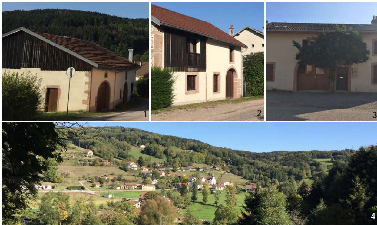
1 / 2 / 3/ Ramée en bois, traditionnelle ou contemporaine, enduit clair, poirier de façade et mise en valeur des encadrements de baies en grès pour des réhabilitations respectueuses du patrimoine 4/ La toiture en terre cuite s'impose comme une évidence sur les constructions
