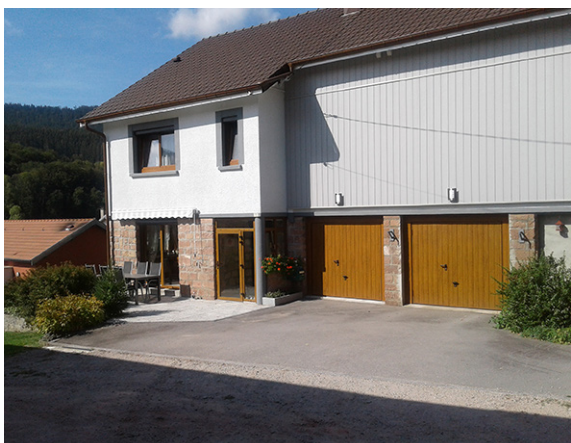
Exemple d'une ferme de la reconstruction qui a maintenu les matériaux traditionnels (soubassement en pierres, anciens engrangements en bardage de planches, ...) dans le cadre de sa réhabilitation.
