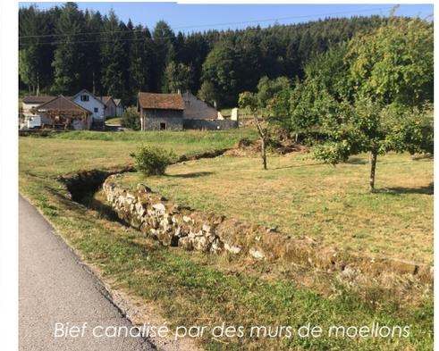
Bief canalisé par des murs de moellons
