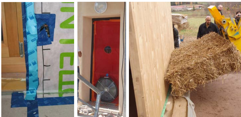
Exemple de mises en oeuvre et de systèmes visant la performance énergétique et la réduction des carbone : étanchéité à l'air, test d'étanchéité à l'air et construction bois isolée en bottes de paille (Gerbépaille - Le Toit Vosgien à Gerbépail).
