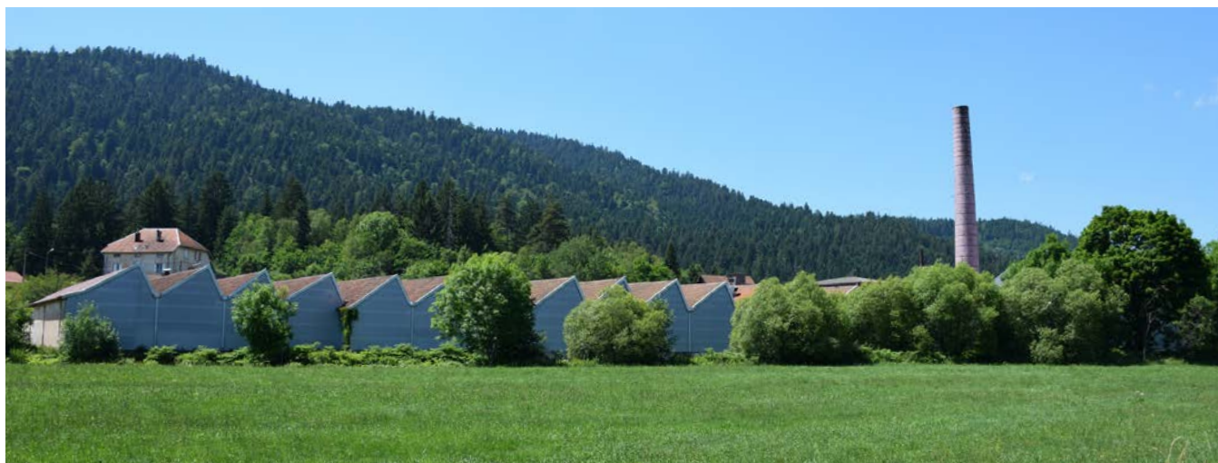
Les sheds et la cheminée de l'usine Bleu Forêt le long de la Moselotte à Vagney. : les sites industriels offrent un potentiel intéressant pour le développement des dispositifs d'ENR, par exemple de photovoltaïque en toiture
