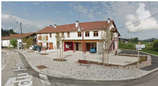
Création d'un espace public de centre-bourg à l'emplacement de l'ancienne cour d'école à Champdray
