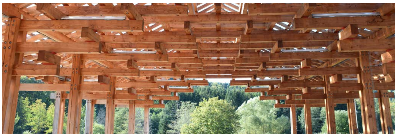
Halle en bois local à Tendon
