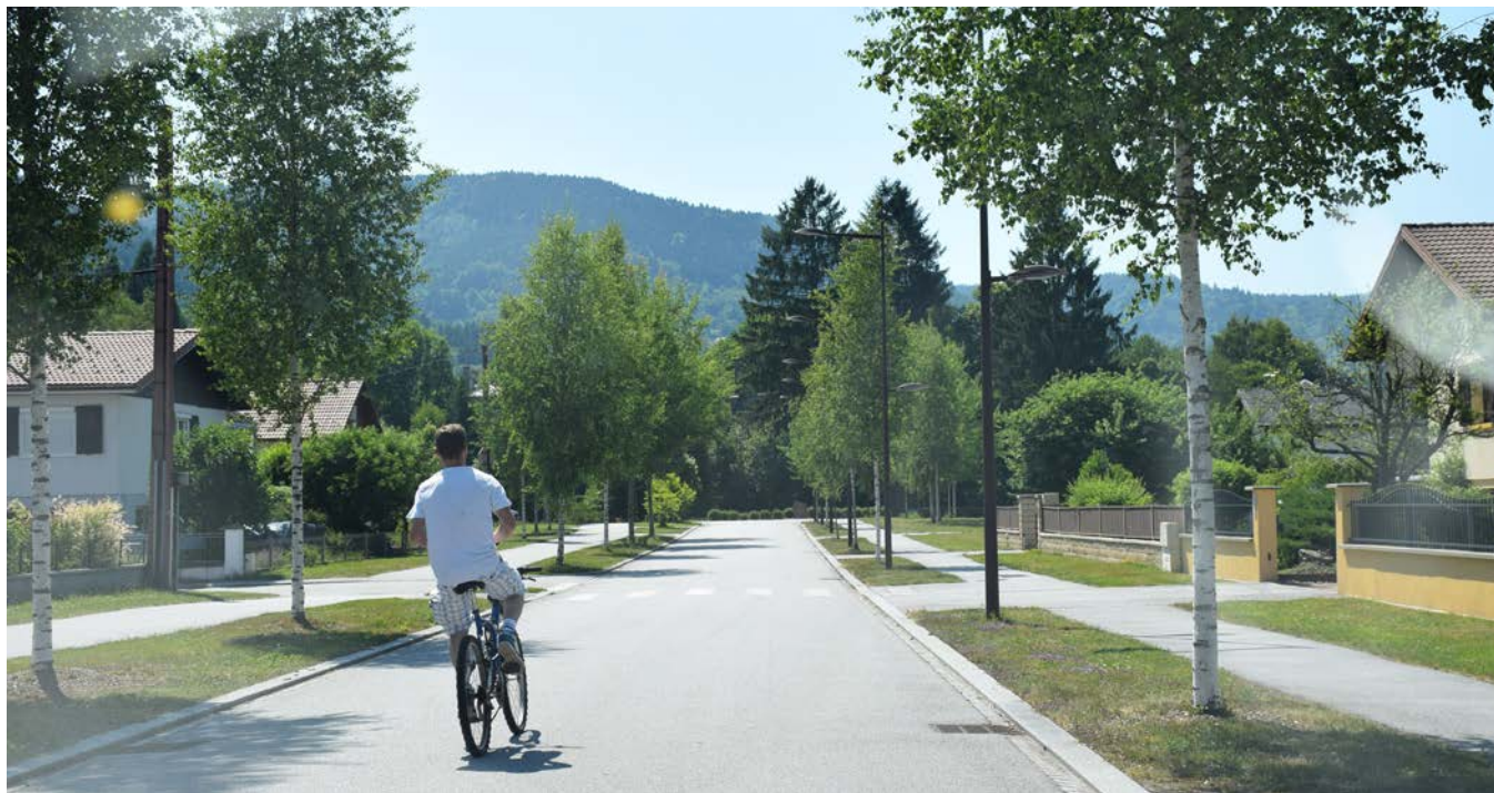
Requalification d'une rue favorable aux modes doux et limitant les surfaces imperméables à Saulxures-en-Moselotte
